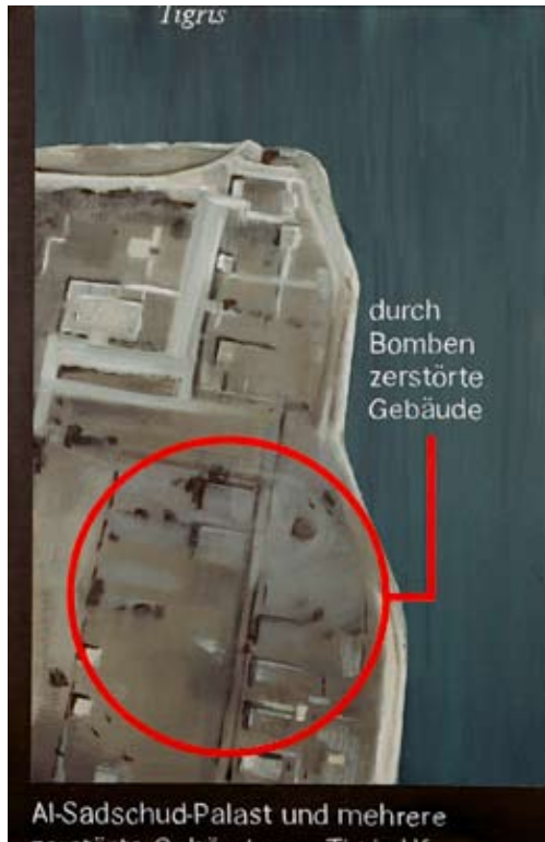
Durch Bomben zerstörte Gebäude 2 · 2006 · 55 x 85cm
